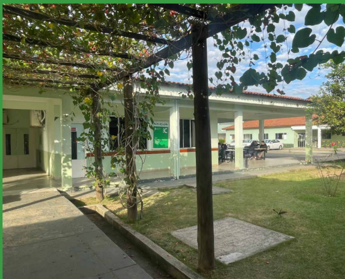
Foto 46. Área entre o bloco B e C
