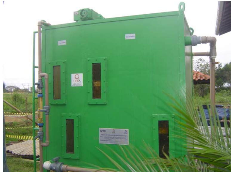
Figura 13 – Floculador e Decantador
