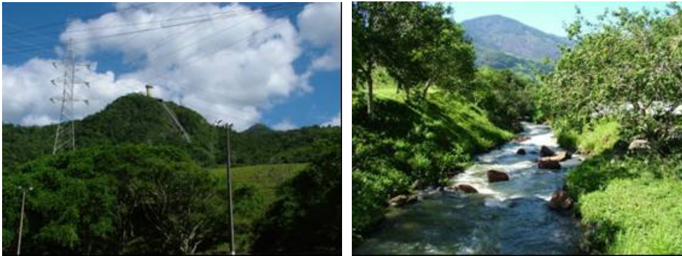
Figura 62 – Canalização das águas da bacia do rio Macabu e sua chegada no córrego do Sertão, afluente do rio São Pedro.
