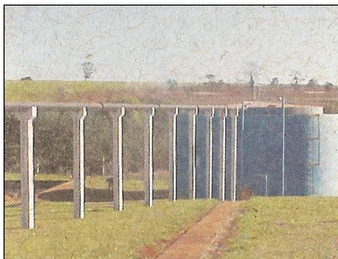
Figura 4: Reator UASB. Fonte: Menezes (2005).
