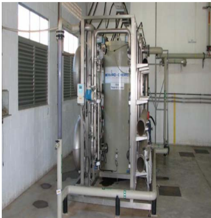
Ilustração 80 - Tecnologia de Tratamento Aeróbio implantado na Altana-Pharma em Jaguariúna, São Paulo Fonte: Envirochemie, 2008
