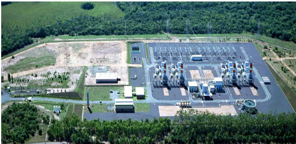
Ilustração 75 - Fotografia aérea da UTE-LCP UTE - LCP – Usina Termelétrica Luís Carlos Prestes Usina Termelétrica a Gás Natural em Ciclo Simples , Três Lagoas – MS - Brasil
