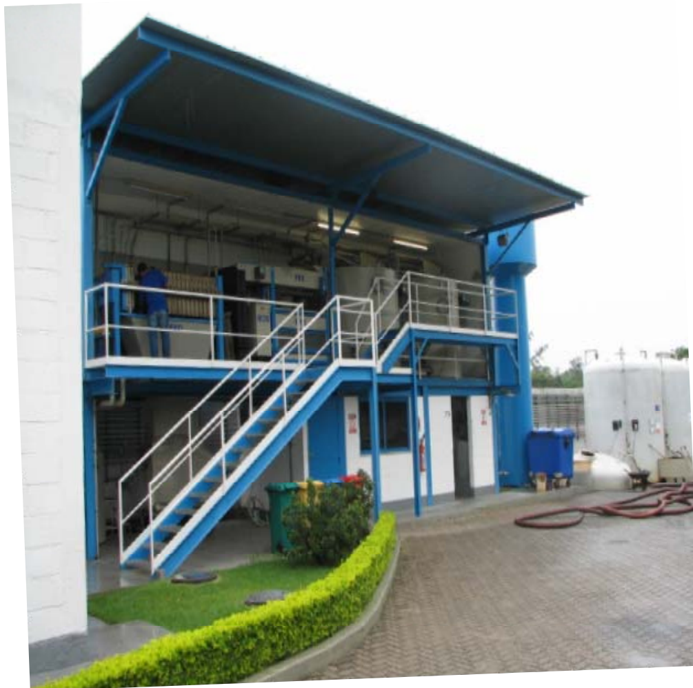
Ilustração 84 - Tecnologia Para Tratamento de Pequenos Volumes implantado na Envirochemie, Rio de Janeiro
