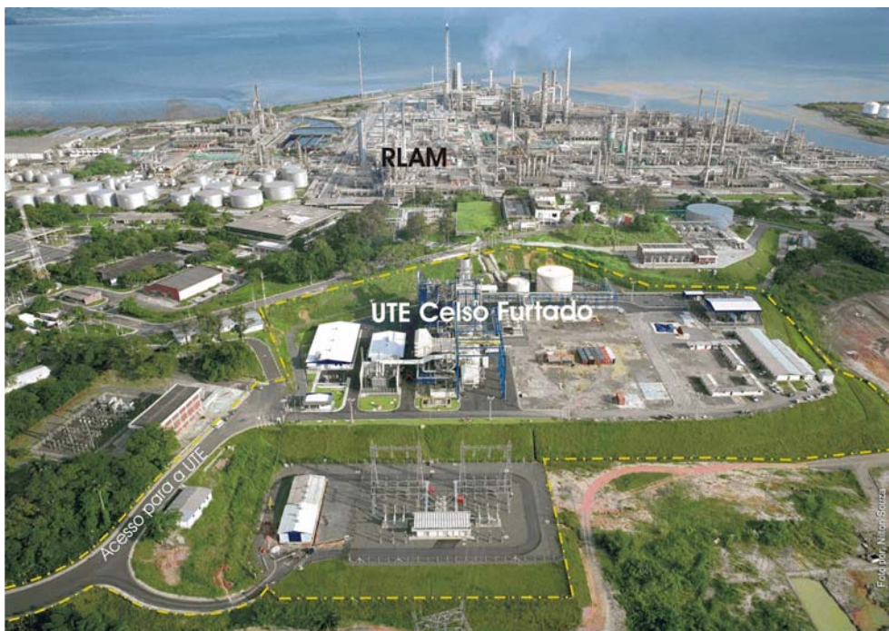
Ilustração 73 - UTE CF – Usina Termoeletrica Celso Furtado - Usina de geração termelétrica a gás natural, ciclo combinado e co-geração de vapor.
