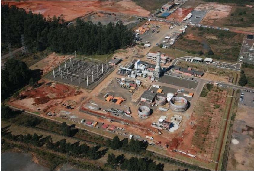
Ilustração 72 - UTE-ST - Usina Termelétrica Sepé Tiaraju, geração termelétrica com turbina a gás de ciclo simples, localizada em Canoas, Rio Grande do Sul.
