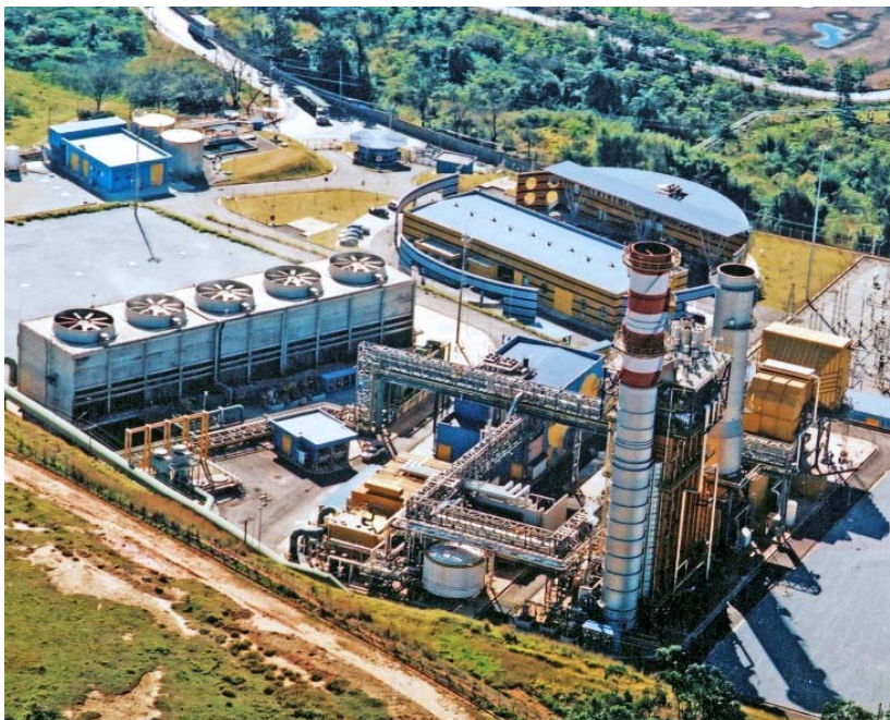
Ilustração 71 - UTE Aureliano Chaves - Usina de geração termelétrica à gás natural, ciclo combinado. Fonte: UTE ACH IBIRITÊ -MG
