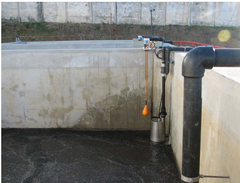
Ilustração 78 - Detalhe do Tratamento Biológico implantado pela Envirochemie
