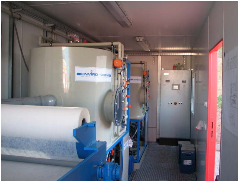
Ilustração 79 - Detalhe do Tratamento Físico-Químico implantado pela Envirochemie Fonte: Visita Técnica de Campo na Halliburton, Macaé
