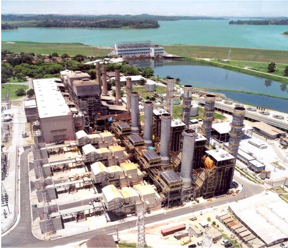
Ilustração 74 - Complexo Termelétrico Piratininga (UTE-FEG e UTE-Piratininga) UTE - FEG – Usina Termelétrica Fernando Gasparian Usina Termelétrica a Gás Natural em Ciclo Combinado
