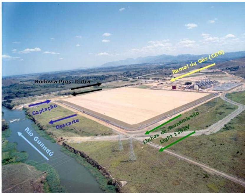
Ilustração 70 – Detalhes do Lançamento de Efluentes da UTE BLS no corpo hídrico receptor Rio Guandú Fonte: Visita Técnica de Campo - SIMPEP, 2007
