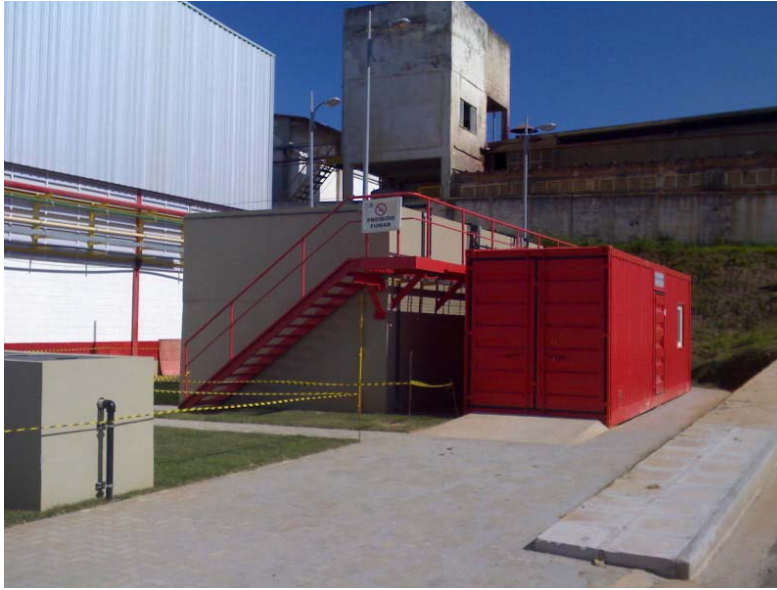
Ilustração 77 - Estação de Tratamento de Efluentes com Tecnologia de Tratamento Físico Químico e Biológico pela Envirochemie
