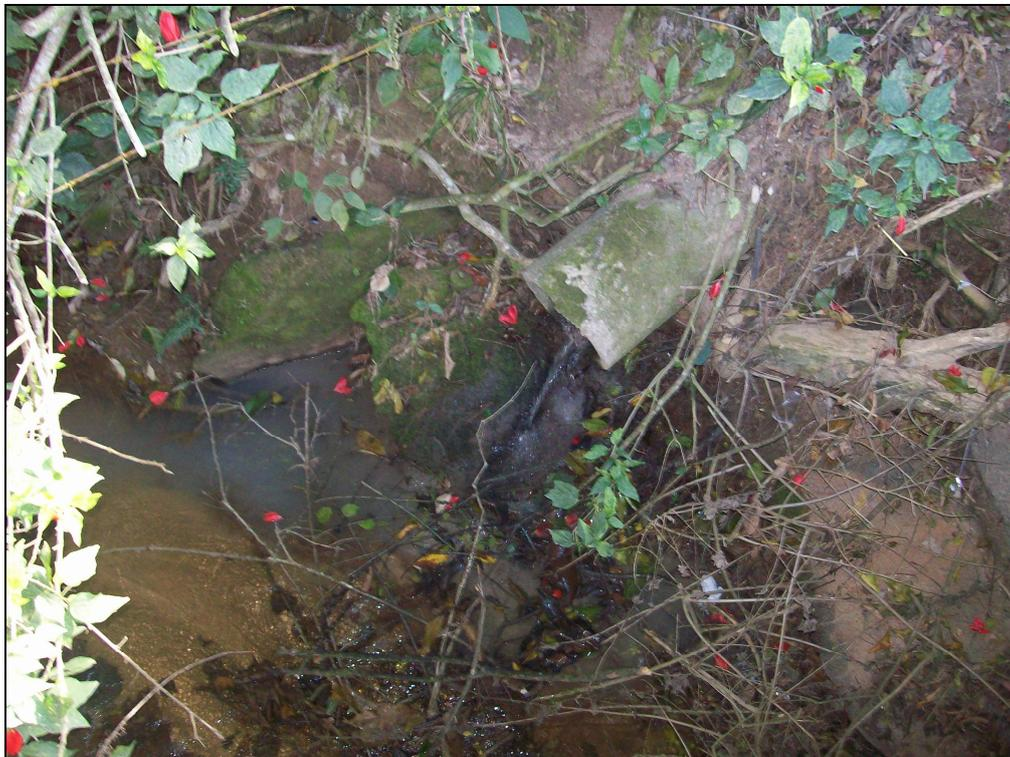
**Foto 7** – Tubulação lançando efluentes domésticos sem tratamento no córrego do Santana, no arraial do Sana.
