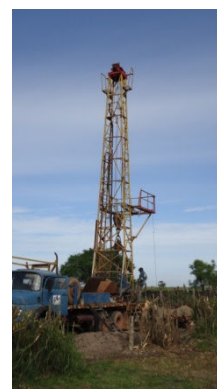
Figura 10b: Perfuração do poço na localidade de Palacete.
