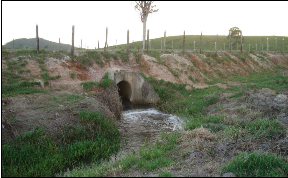
Foto 5: Vista do ponto de coleta 3 (PC 03). Travessia sob o asfalto. 24/06/09.
