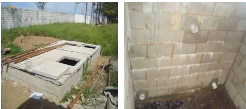
Figura 5 – Fossa séptica em construção Figura 6 – Vista interior da fossa Séptica Fonte: Elaboração própria.
