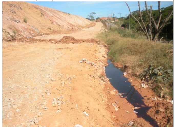
Figura 35: Aterro de Cabiúnas. Percolação de chorume proveniente da decomposição do lixo. Fonte: Fotos da Autora (2009).
