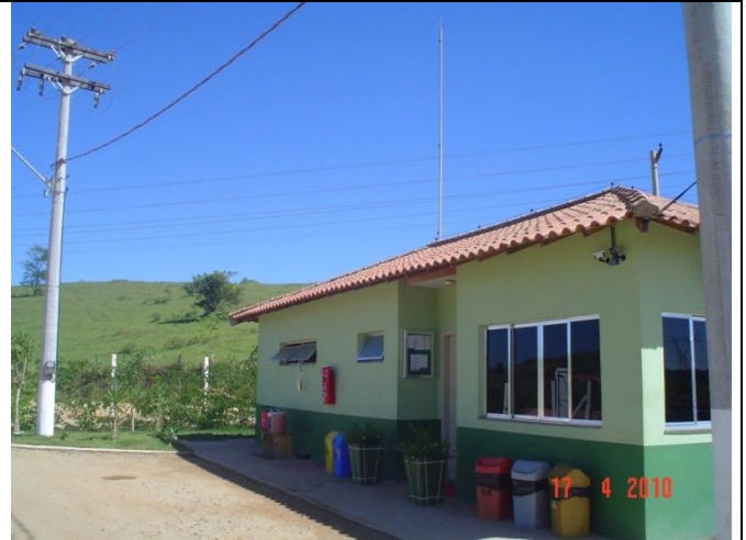
Figura 39: Prédio administrativo contendo sala, banheiro e refeitório. Fonte: Fotos da Autora (abr, 2010).
