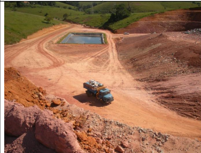
Figura 46: Lagoa de acumulação de percolados. Fonte: Fotos da Autora (mai, 2009).
