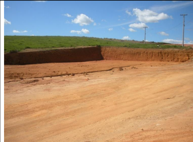
Figura 44: Área sendo preparada para receber instalação da central de tratamento dos RSS. Fonte: Fotos da Autora (mai, 2009).
