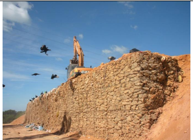
Figura 29: Aterro de Cabiúnas. Área de transbordo. Fonte: Fotos da Autora (2009).
