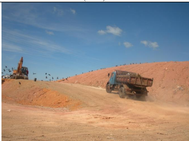
Figura 30: Aterro de Cabiúnas. Área de transbordo. Fonte: Fotos da Autora (2009).
