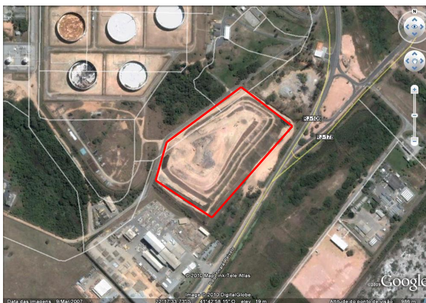
Figura 25: Aterro Municipal de Cabiúnas. Fonte: Google earth , 2007.
