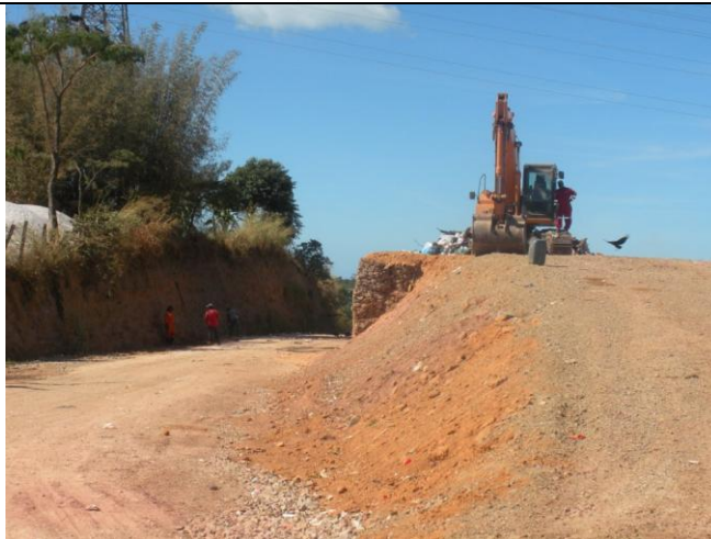
Figura 28: Aterro de Cabiúnas. Área de transbordo. Fonte: Fotos da Autora (2009).
