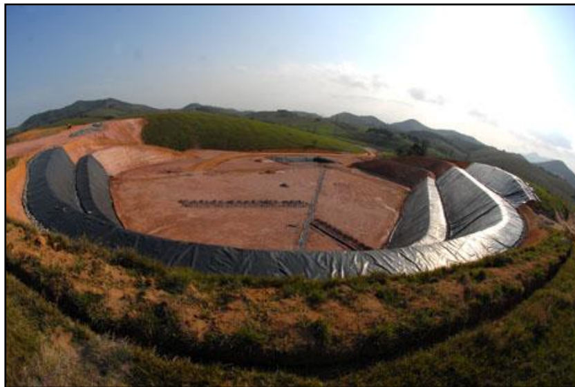
Figura 37: Foto do novo Aterro Sanitário de Macaé. Fonte: site Jornal Repórter Online Bom Jesus do Itabapoana e região, 2008.
