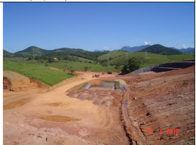
Figura 49: Visão geral do aterro. Fonte: Fotos da Autora (abr, 2010).
