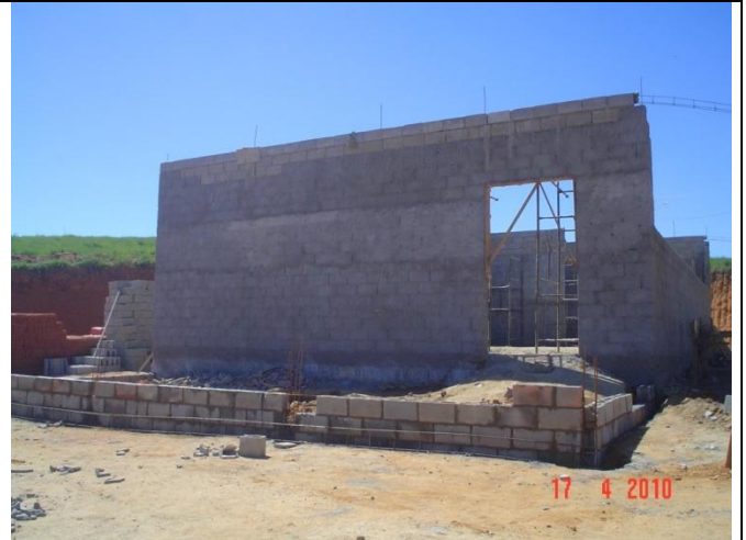
Figura 45: Central de tratamento dos RSS sendo instalada para receber 3 autoclaves. Fonte: Fotos da Autora (abr, 2010).
