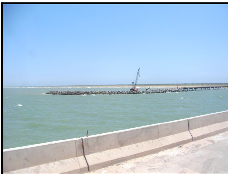
FIGURA 7 – Construção em fase final do píer secundário para auxílio da construção do quebra-mar de abrigo principal. Fonte: Autora, 2009.
