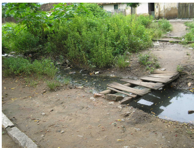
Figura 26: Condições críticas de saneamento básico, com esgoto lançado em uma vala numa das ruas da comunidade de Santa Cruz, em Campos dos Goytacazes (RJ).
