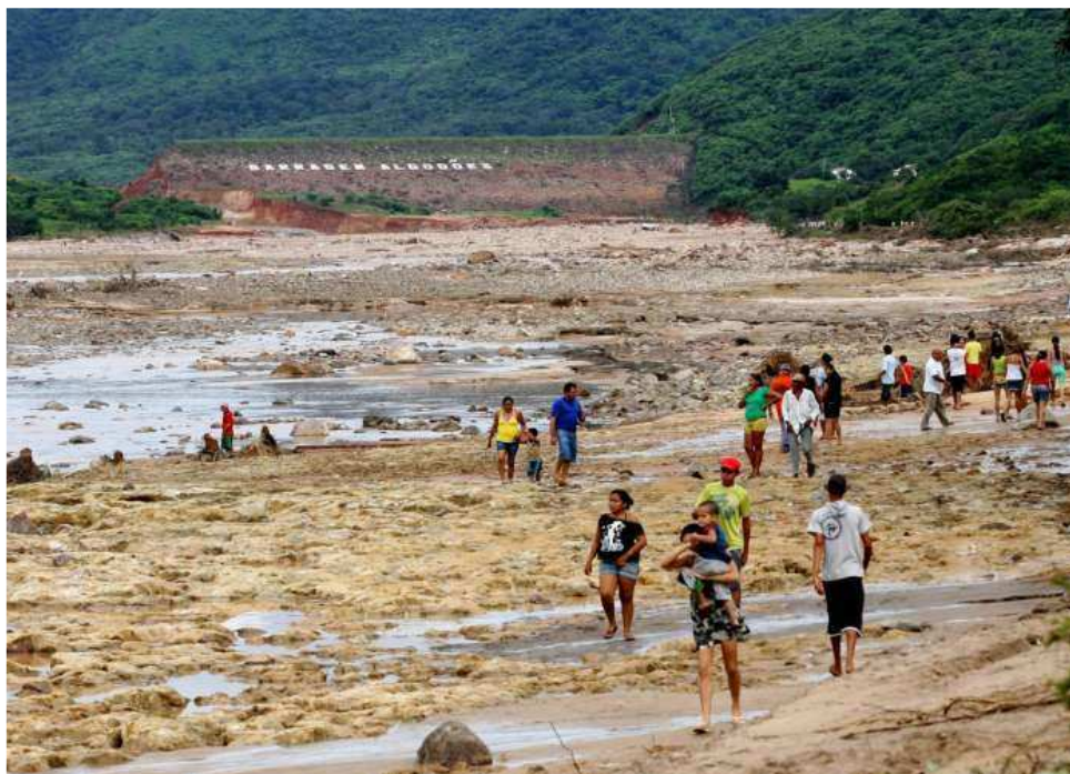
Figura 4: Desabrigados após rompimento da barragem. Fonte: http://www.ecodebate.com.br/2009/06/01/rompimento-da-barragem-algodoes-i-rio-seca-e-o-drama-agora-e-com-socorro/ . Acesso em 14.08. 2009.
