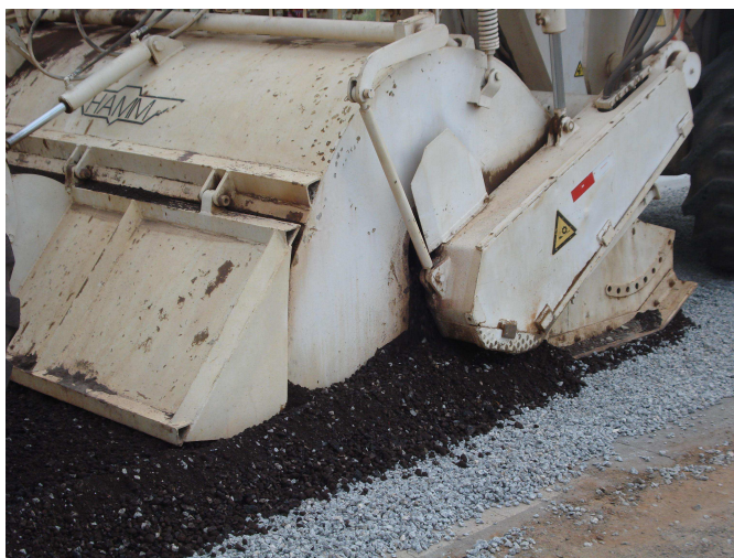
Figura 26 – Restauração da BR 356. Trecho que liga Campos dos Goytacazes a São João da Barra (Agosto de 2010).
