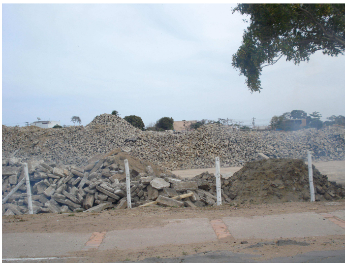
Figura 14 - Área de transbordo de RCC no município (Abril de 2009).
