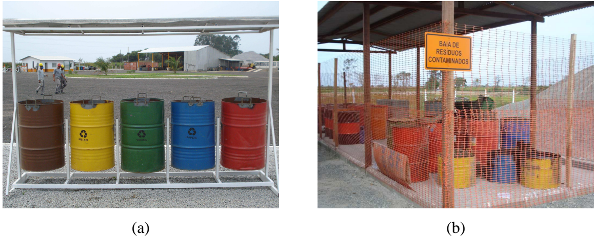
Figura 16 – Acondicionamento separado para cada tipo de resíduo no canteiro de obras (Julho de 2010).
