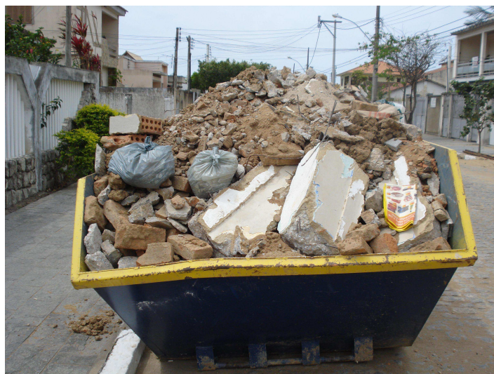
Figura 25 – Caçamba no seu limite de capacidade para acondicionamento de RCC (Agosto de 2009).
