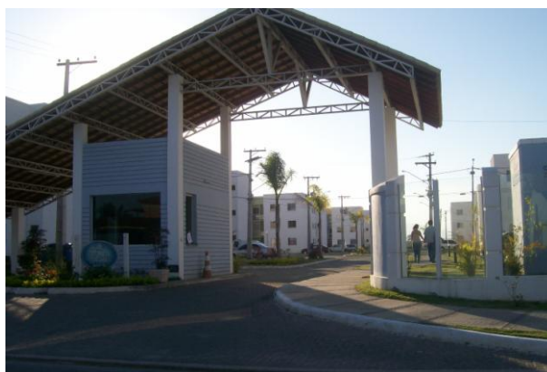
Foto 21: Condomínio em Jardim Mariléia, Rio das Ostras – RJ, 2009. Fonte: M. L. M. GOMES, 2009
