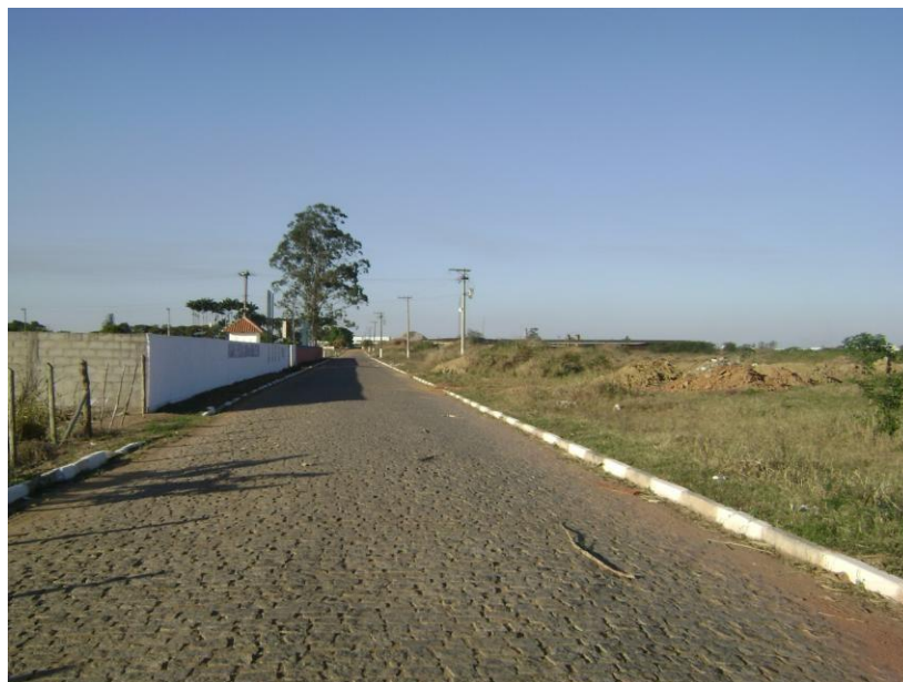
Figura 46:Foto da Rua projetada 13/ deposição de RDC
