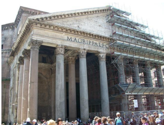
Figura 2: Panteon de Adriano em restauração.
