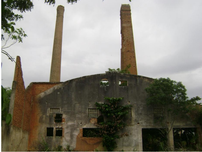
Figura 40: Foto da área da usina desativada –
