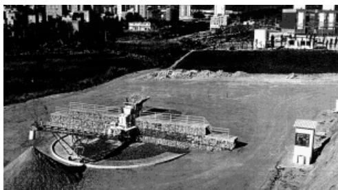
Figura 9: Usina de reciclagem de entulho de Belo Horizonte
