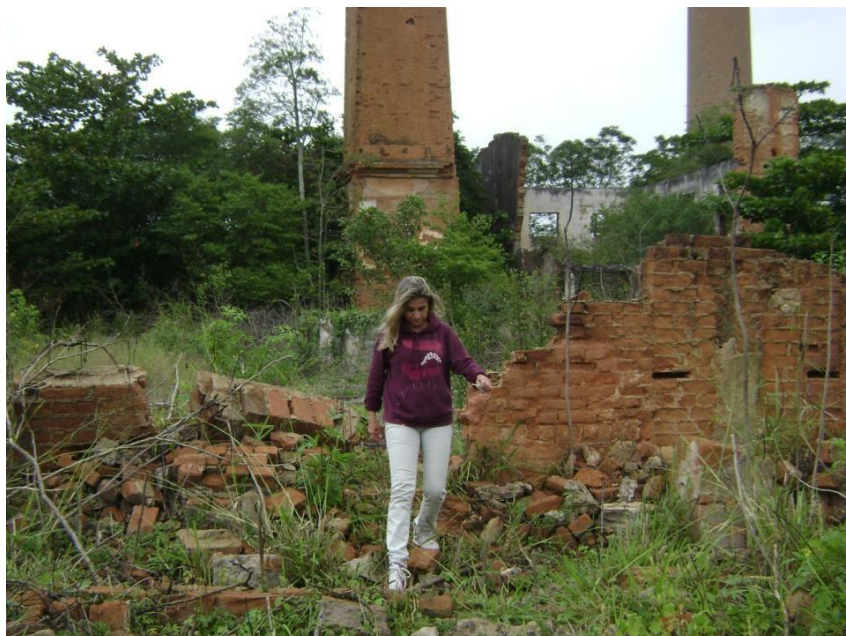
Figura 41 : Foto da área da usina desativada
