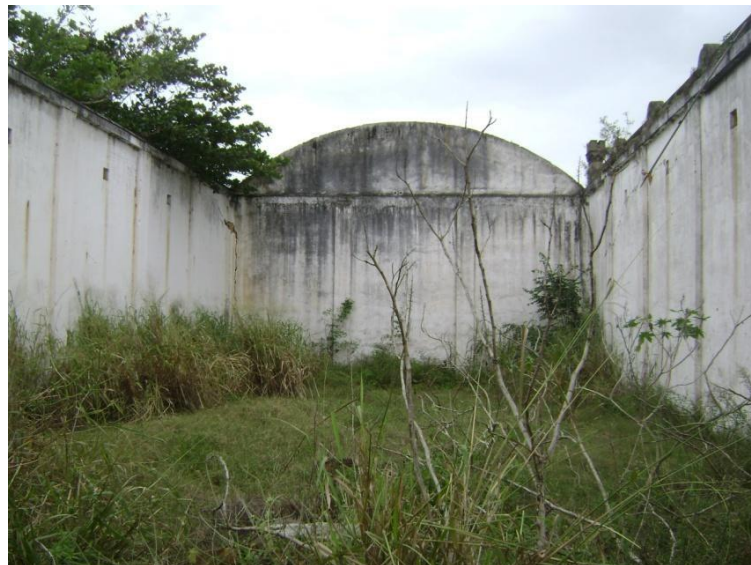
Figura 39: Foto da área da usina desativada –
