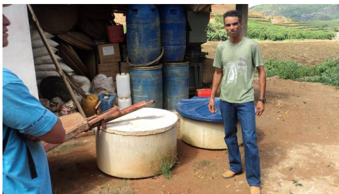
Figura 10. Manilhas que farão a proteção das nascentes 1 e 2.
