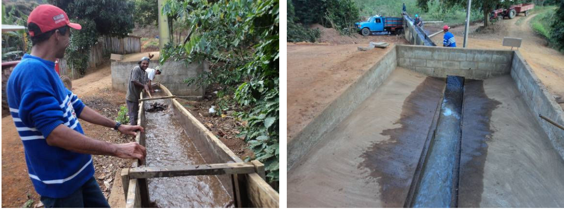
Figura 14. À esquerda o lavador antes da retirada dos “pés” de café e, à direita, a nova rampa para descarregar o café. Fonte: Cristiano Peixoto Maciel, 2010.
