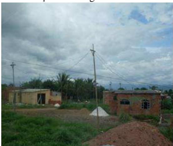
Figura 25- Improvisação de rede de captação e distribuição de energia
