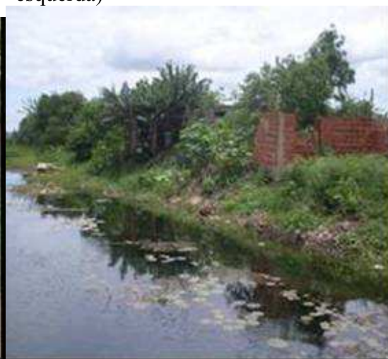
Figura13-Aterramento da FMP para de construção de moradias (margem esquerda)
