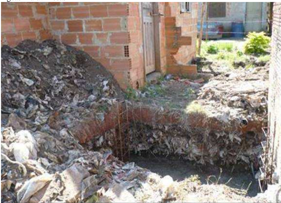
Figura 11 - Ilustração das condições gerais da base de edificação de moradias em Águas Maravilhosas
