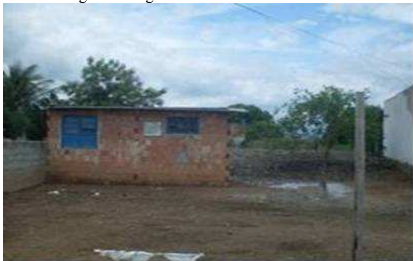
Figura14-Esgotamento sanitário a céu aberto
