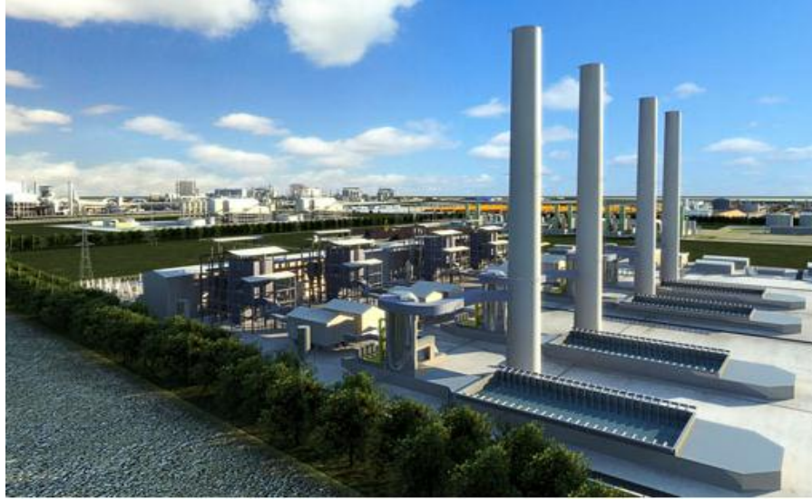
FIGURA 22: Usina Termoelétrica à Carvão Mineral, localizada em São João da Barra (RJ). Fonte: MPX – Uma Empresa do Grupo EBX. Disponível em: http://www.mpx.com.br/pt/nossos-negocios/geracao-de-energia/projetos/Paginas/mpx-acu-I.aspx
