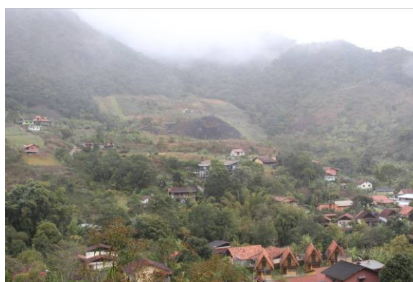
Figura 6. Construções em zonas de risco. São Pedro da Serra/RJ Foto: Francisco Brant
