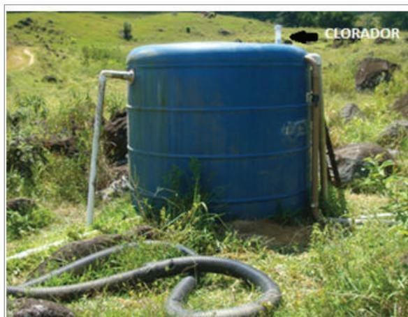
Foto 2: Reservatório de cloração e distribuição.
