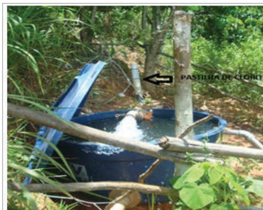
Foto 1b: Reservatório de Cloração e distribuição
