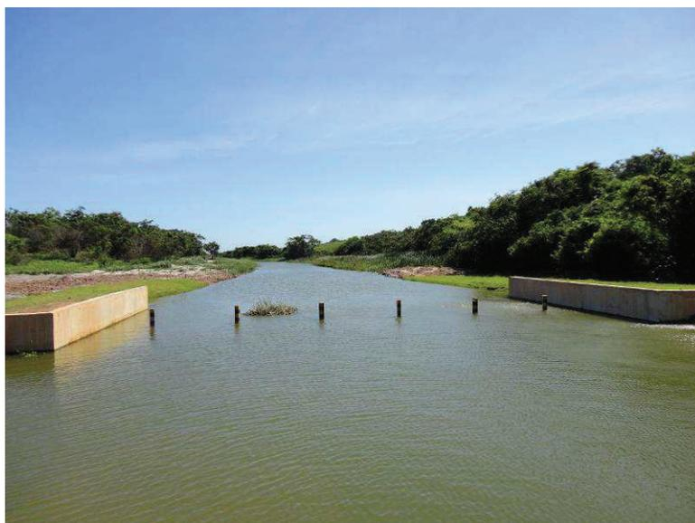
**Figura 9.** Canal extravasor e vertedouro da lagoa Imboassica.
