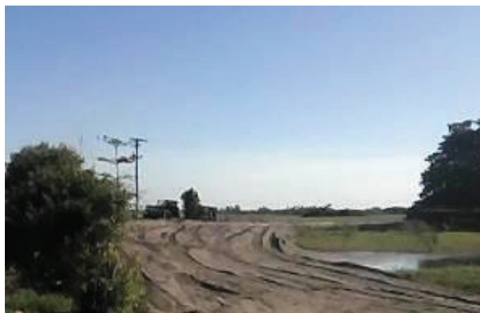
Figura 5 – Obstrução do canal do Brejo Comprido. Fonte: Denis Toledo, 2012.
