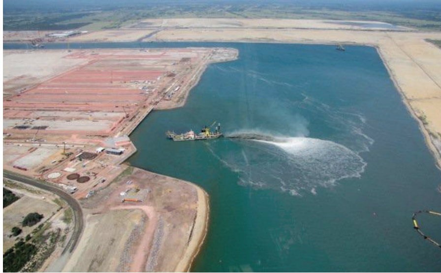
Figura 7 – Dragagem do canal para aumento do calado. Fonte: Roberto Moraes, 2013.
