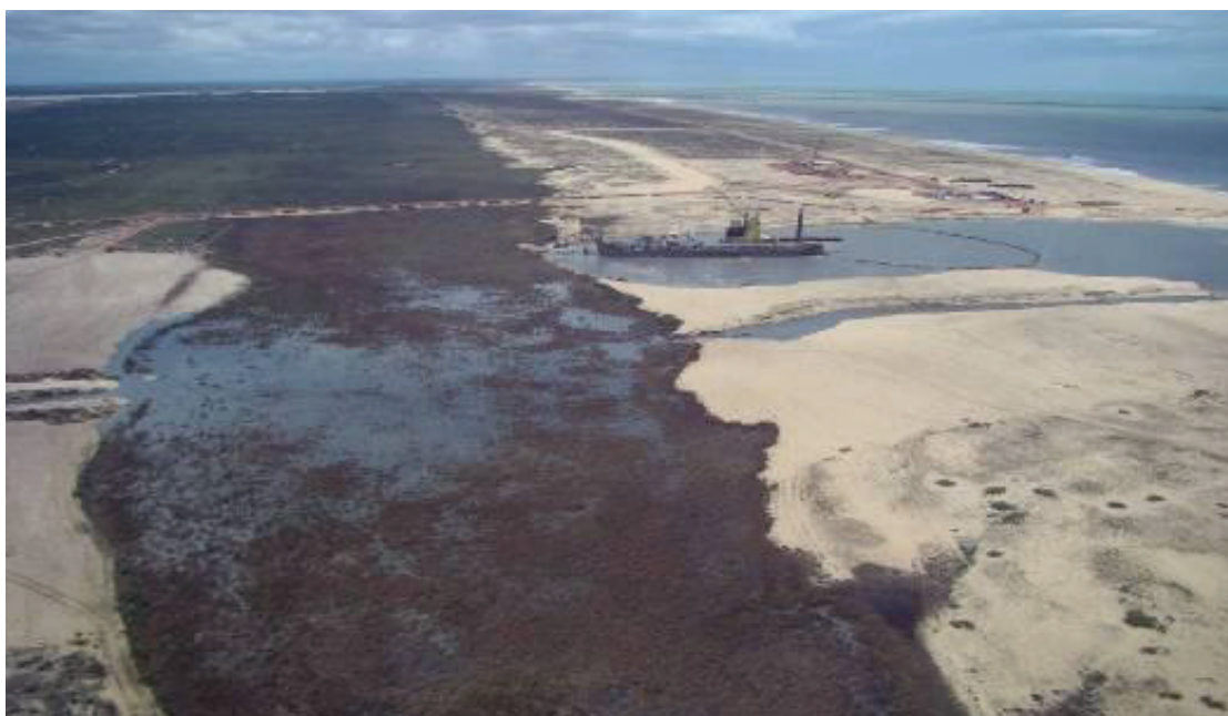
Figura 6 – Dragagem do canal de acesso ao terminal TX-2. Fonte: Roberto Moraes, 2011.
