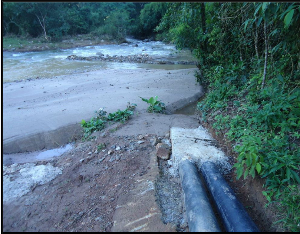
Figura 18: Local de Captação de Água para População de Conceição de Macabu (Sedimentação decorrida da erosão acelerada em áreas desmatadas geram transtornos para os serviços públicos).
