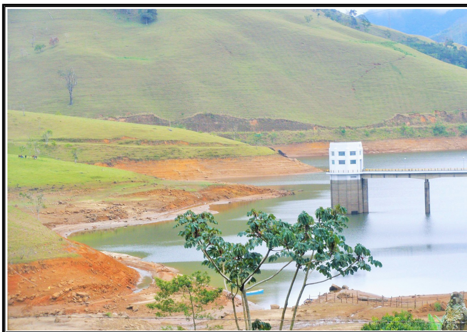
Figura 15: Lago da Represa do Macabu com Baixo Volume de Água e Casa de Máquinas com Bombas para Transposição das Águas. Fonte: Produção Própria.
