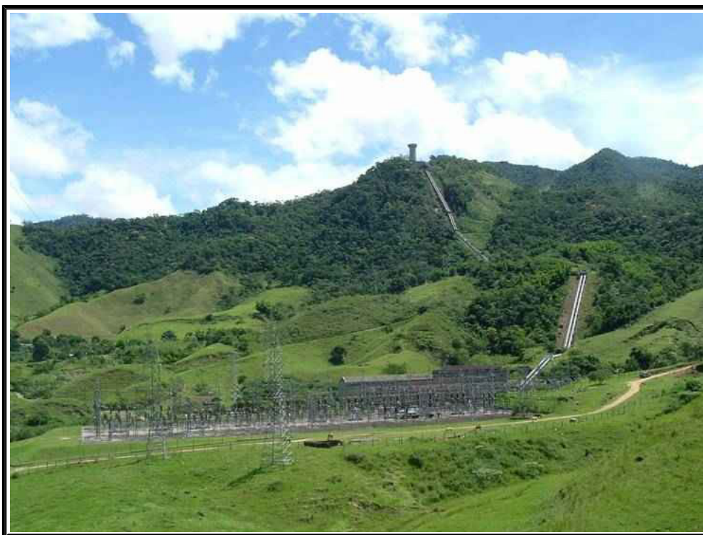
Figura 28 – PCH Macabu e Tubulação em Queda de 336m após transposição por túnel subterrâneo. Fonte: Quanta Geração S/A, 2012. Disponível em: www.quantageracao.com.br
