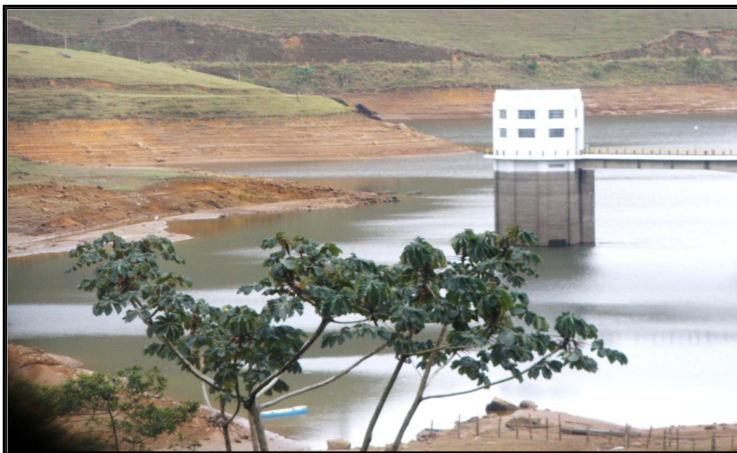
Figura 26: Centro do Reservatório da Represa do Macabu e Casa de Máquinas para Transposição das Águas. Fonte: Produção Própria.
