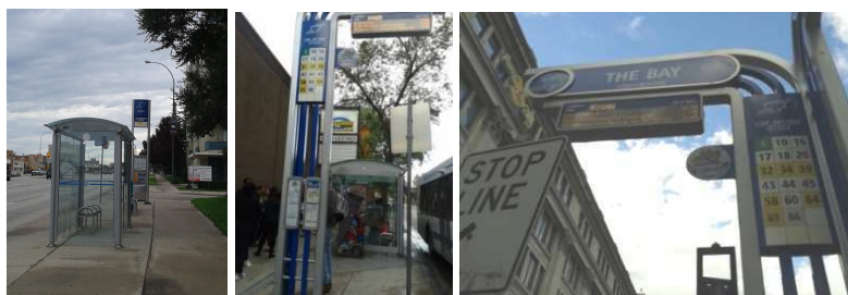
Figura 18 - Ponto de ônibus coberto e com vedação em vidro. Figuras 19 e 20 - Estrutura do ponto de ônibus em local movimentado, onde podem ser vistas a cobertura e o painel eletrônico.
