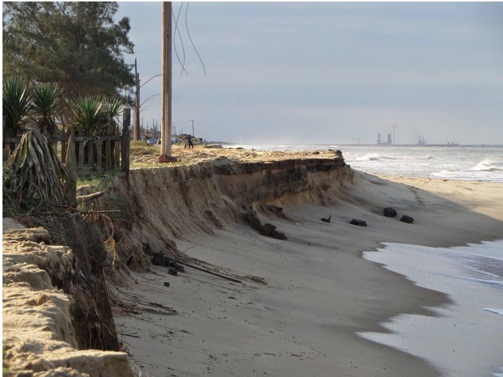
Figura 11- Erosão costeira da Praia do Açu – Março/2015
