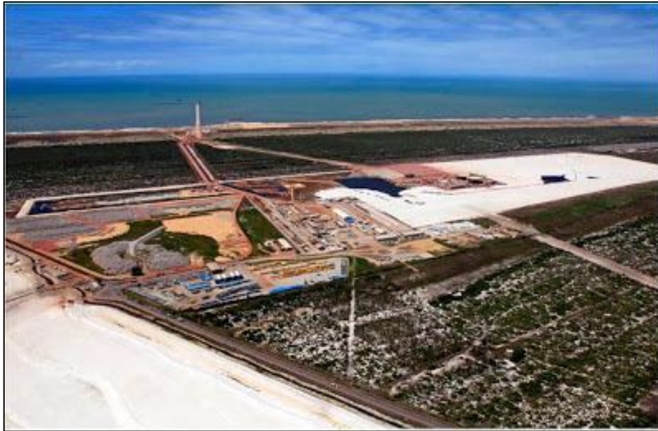
Figura 05. Vista aérea do aterro hidráulico do Complexo Portuário do Açú
