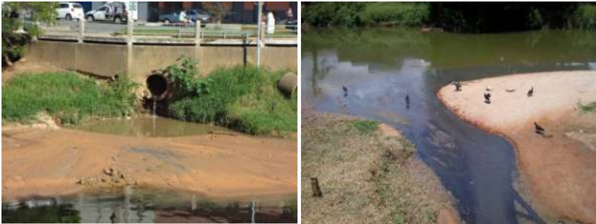
Figuras 4 e 5: Lançamento de esgoto in natura no rio Itabapoana
