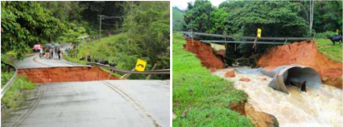
Figuras 9 e 10: Ponte na RJ 230 destruída por um deslizamento de terra, em dez/2013
