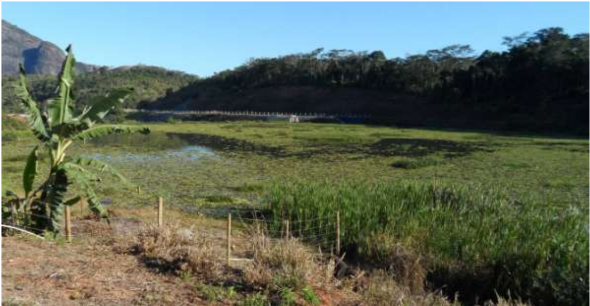
Figura 07: Presença de macrófitas no reservatório da PCH Pedra do Garrafão.
