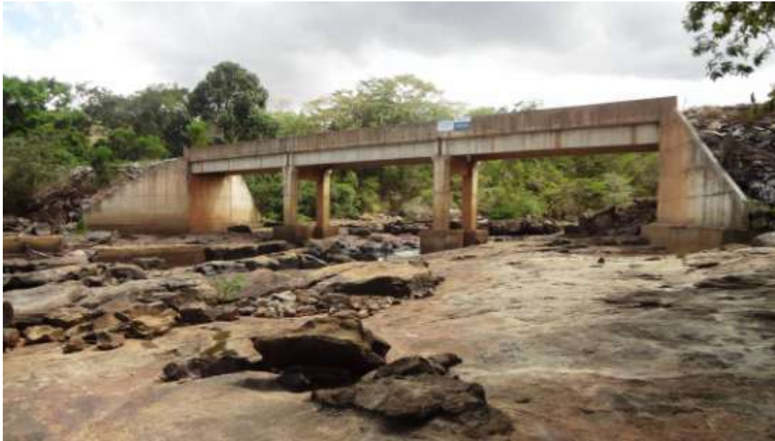
Figura 11: Trecho de Vazão Reduzida da PCH Pedra do Garrafão
