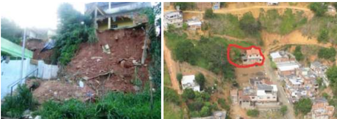
Figuras 7 e 8: Deslizamentos de terra Fontes: Figura 7: Autor ; Figura 8: DRM-RJ (2012)
