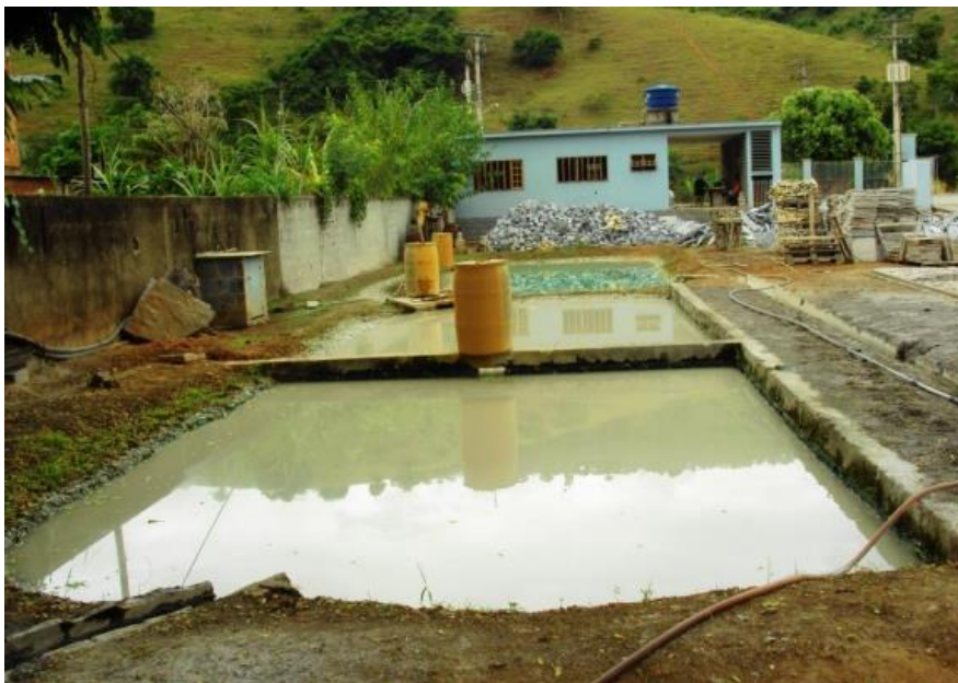
Figura 3: Tanques de decantação. Fonte: Acervo próprio.
