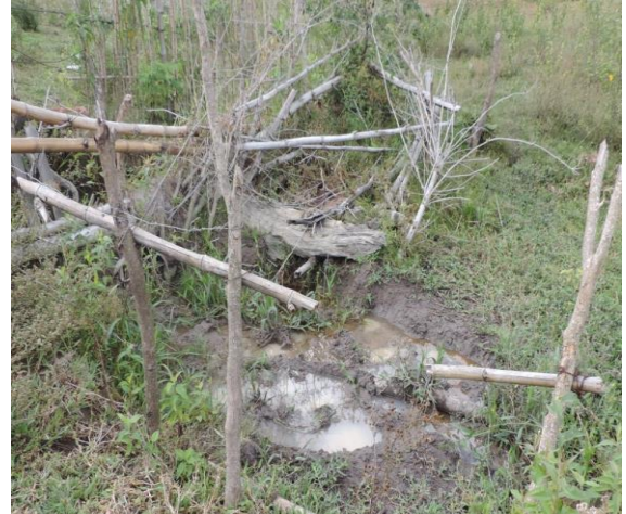
Figura 4 – Proteção com bambus da nascente 1.
