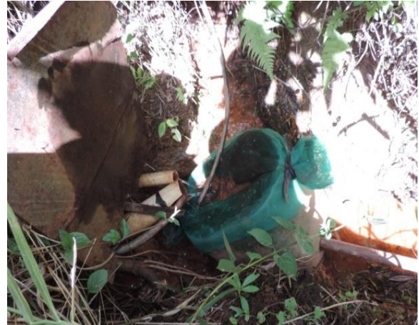
Figura 9 - Estrutura mecânica com balde e filtro de tela plástica da nascente 4.
