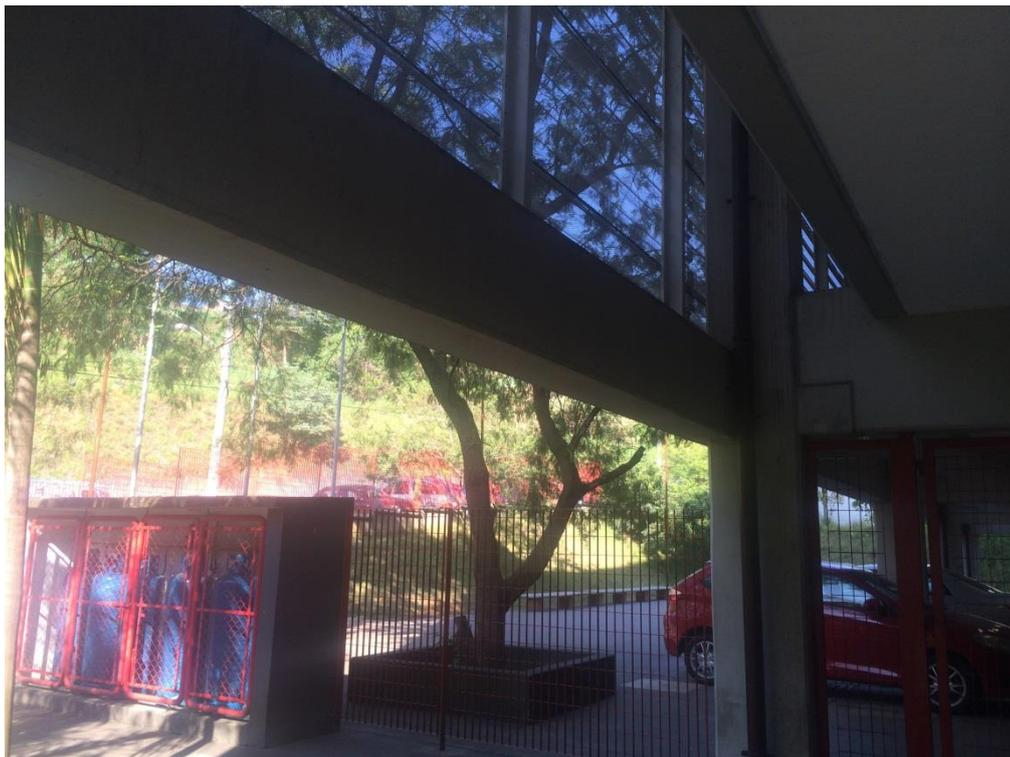
*Figura 4 B– Brise-soleil de chapa perfurada (vista Interna). Fonte: autora (2016)*
