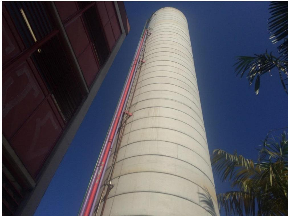
*Figura 8B – Torre de caixa d'água com tubulação identificada por cores.
