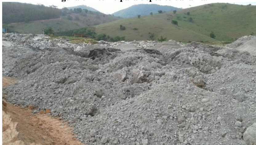
Figura 6- Aterro para depósito da lama.
