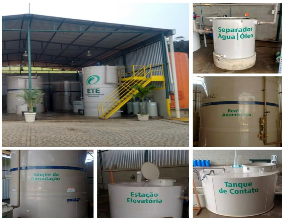
Figura 03 – Visão geral da ETE
