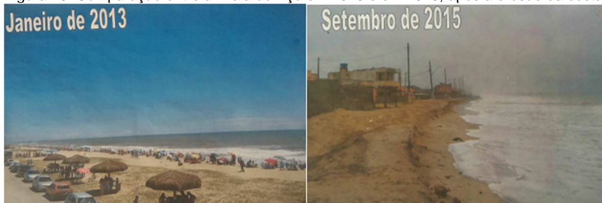
Figura 20: Comparação entre a Praia do Açú em 2013 e em 2015, após a erosão da costa.
