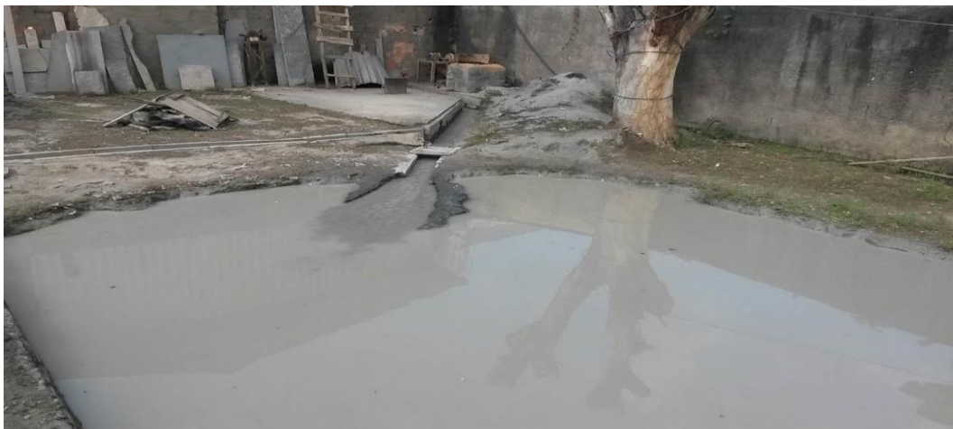
Figura 6 – Ponto 2: Saída de água da serra maior e entrada no primeiro tanque de decantação
