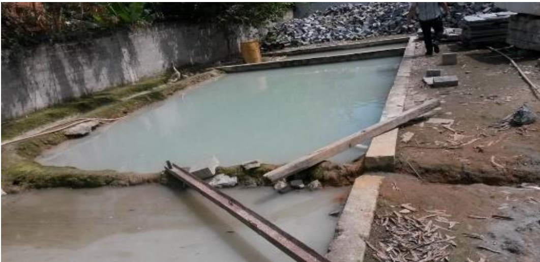
Figura 8 - Pontos 4 e 5: terceiro e quarto tanque de decantação.
