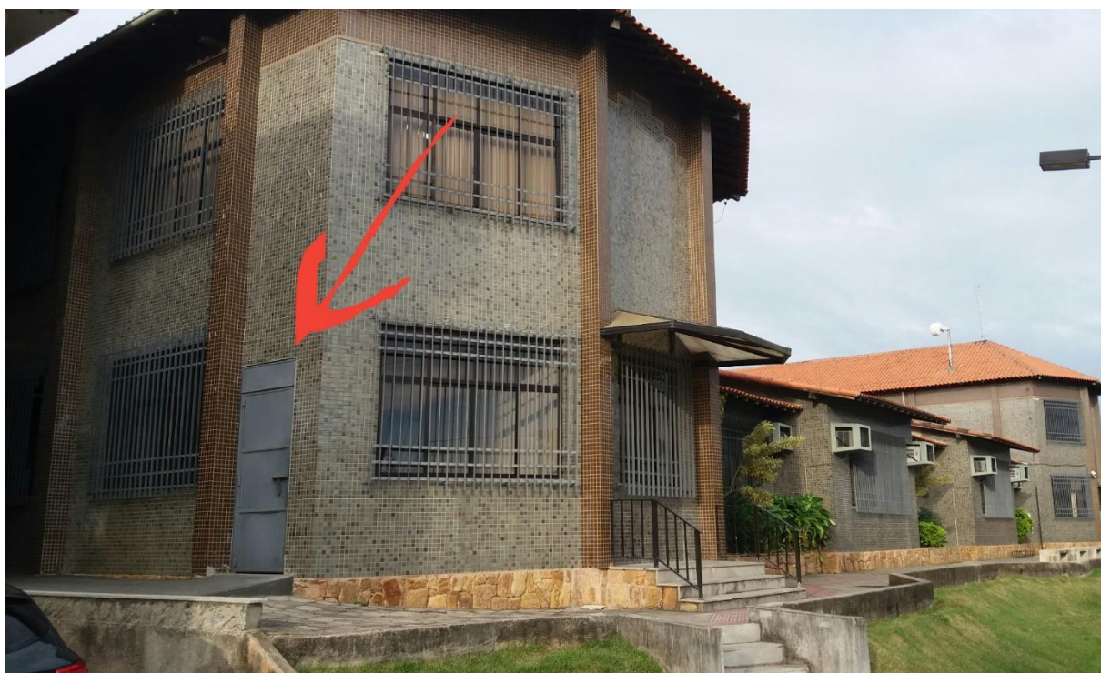
Figura 4: Sala em desuso no prédio com potencial para estocagem de resíduos
