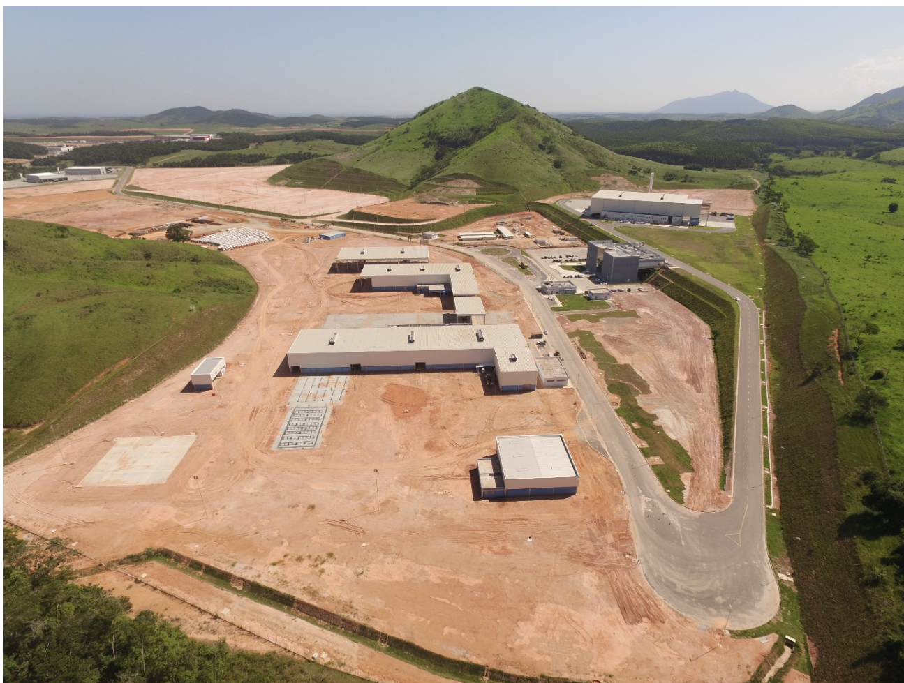
Figura 6: Condomínio Industrial Estrela
