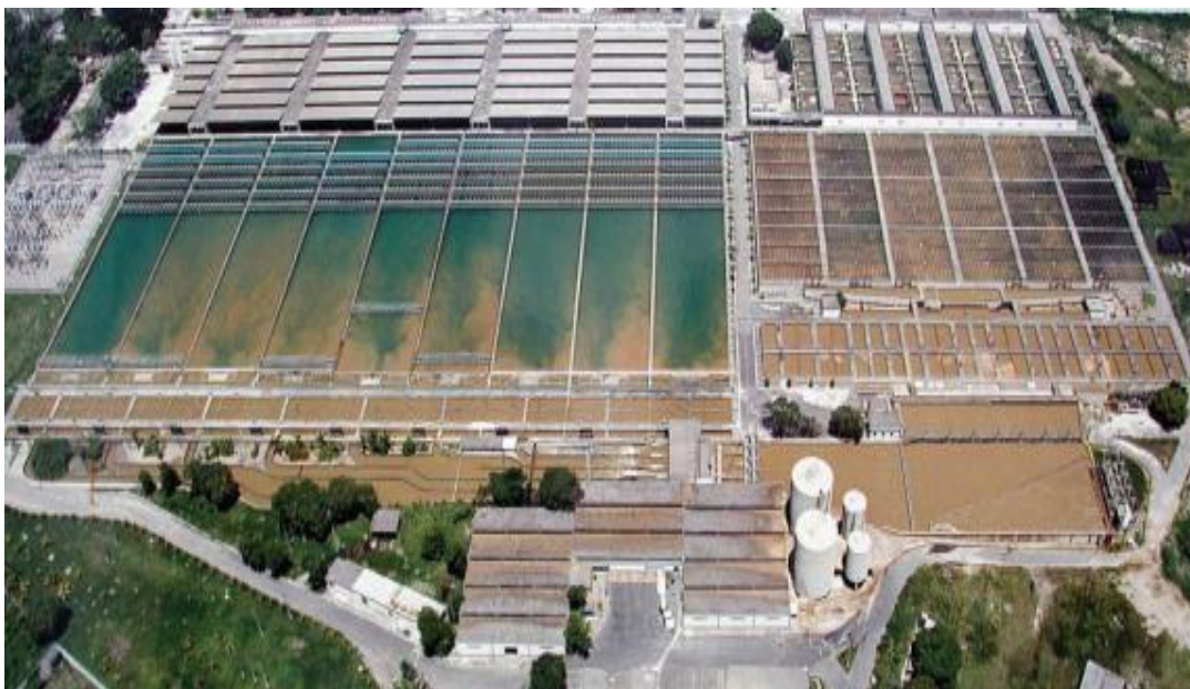
Figura 05 – Visão aérea da ETA de Guandu
