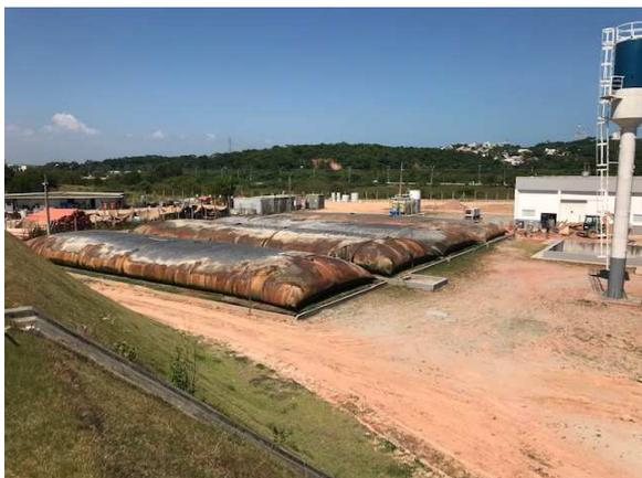
Figura 16 – Geobags de armazenamento de lodo – Fonte: Próprio Autor
