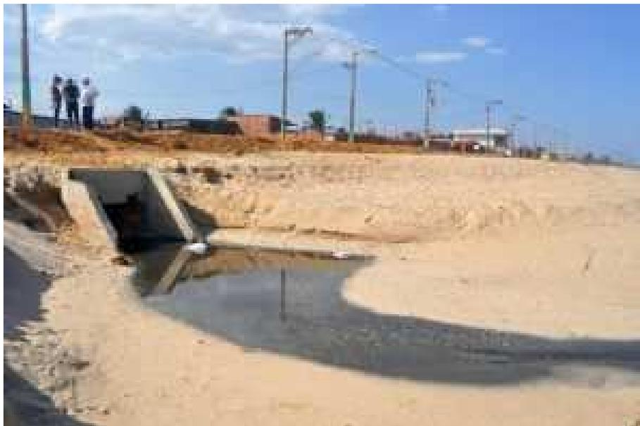
Figura 07 – Lançamento de Esgoto na rede Pluvial – Fonte: Jornal o Debate (Out.2018)
