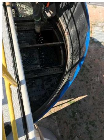
Figura 13 – Aplicação de material filtrante no tanque de tratamento da ETE Mutum – Fonte: Próprio Autor
