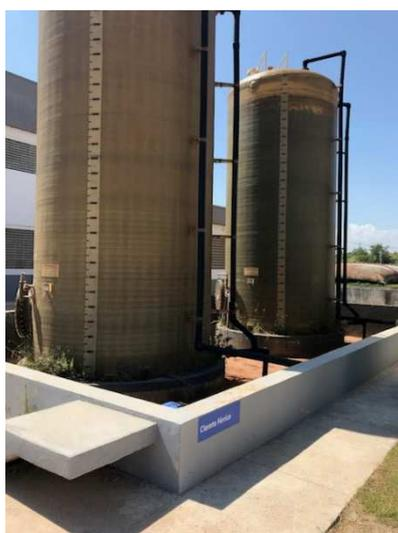
Figura 24 – Estrutura de contenção para prevenir contaminação do solo por produtos químicos – Fonte: Próprio Autor
