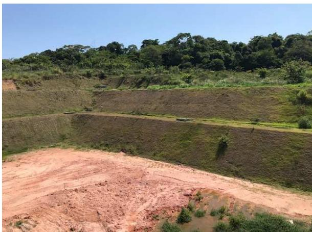
Figura 22 – Talude protegido com grama em torno do platô da ETE Centro – Fonte: Próprio Autor
