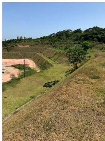
Figura 23 – Talude protegido com grama em torno do platô da ETE Centro – Fonte: Próprio Autor
