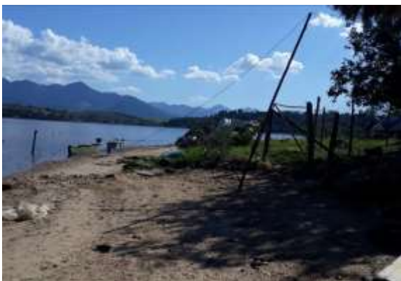
Figura 18: instalação elétrica da Bomba na Lagoa de Cima
