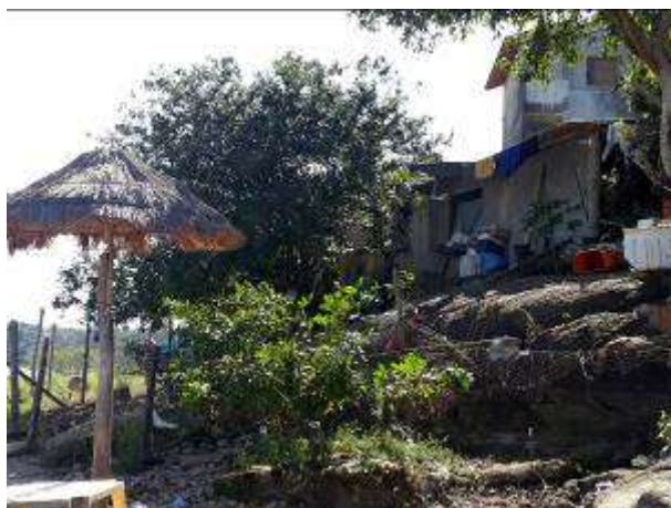
Figura 14: residência na AAP e entulhos
