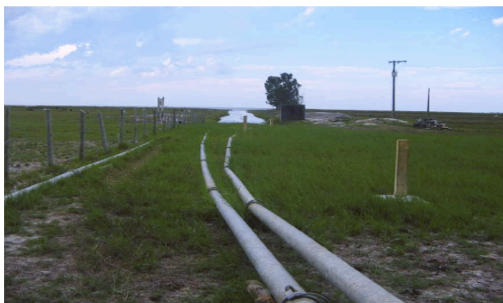
Figura 9 - Modo de tomada de água da Lagoa Feia através de tubulação em ponto fixo.
