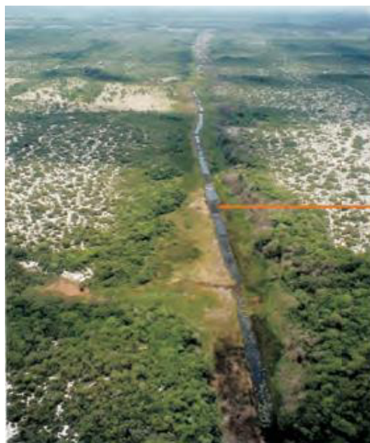
Figura 1- Foto aérea de trecho do Canal Campos Macaé
