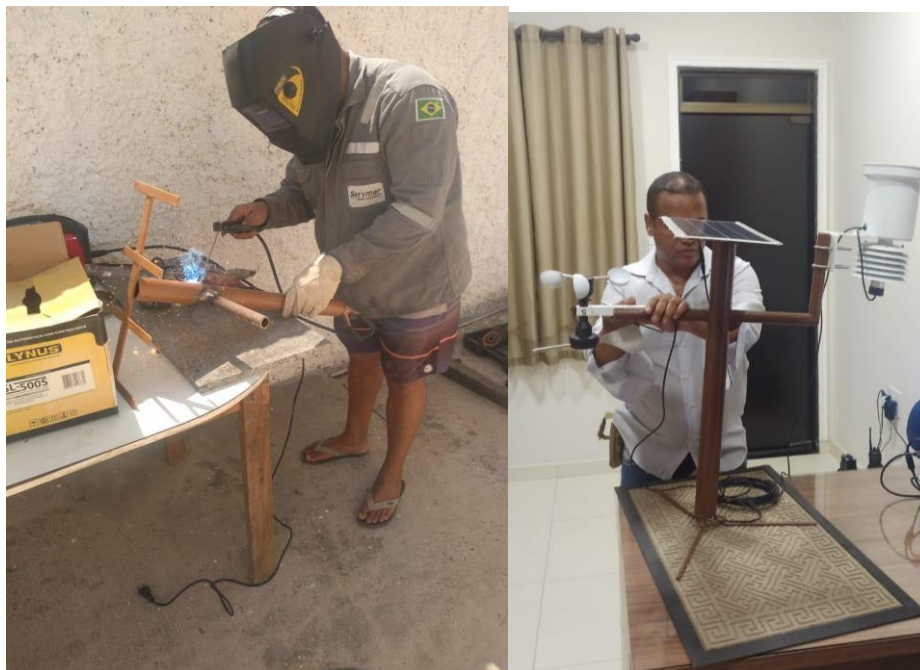
Figura 10 – Montagem protótipo 03 - Serralheria da estrutura da Estação meteorológica e acoplamento dos sensores e componentes
