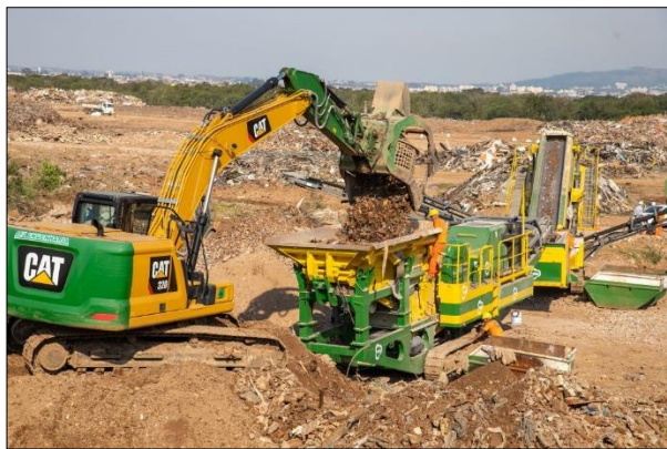
Figura 5 : RCC sendo colocado no britador Fonte: Prefeitura de Canoas (2019)
