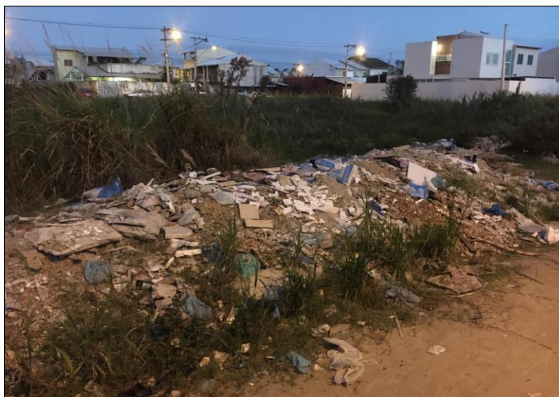
Figura 2: RCC depositado em local irregular no bairro Jardim Botânico em Campos dos Goytacazes Fonte: A Autora (2021)
