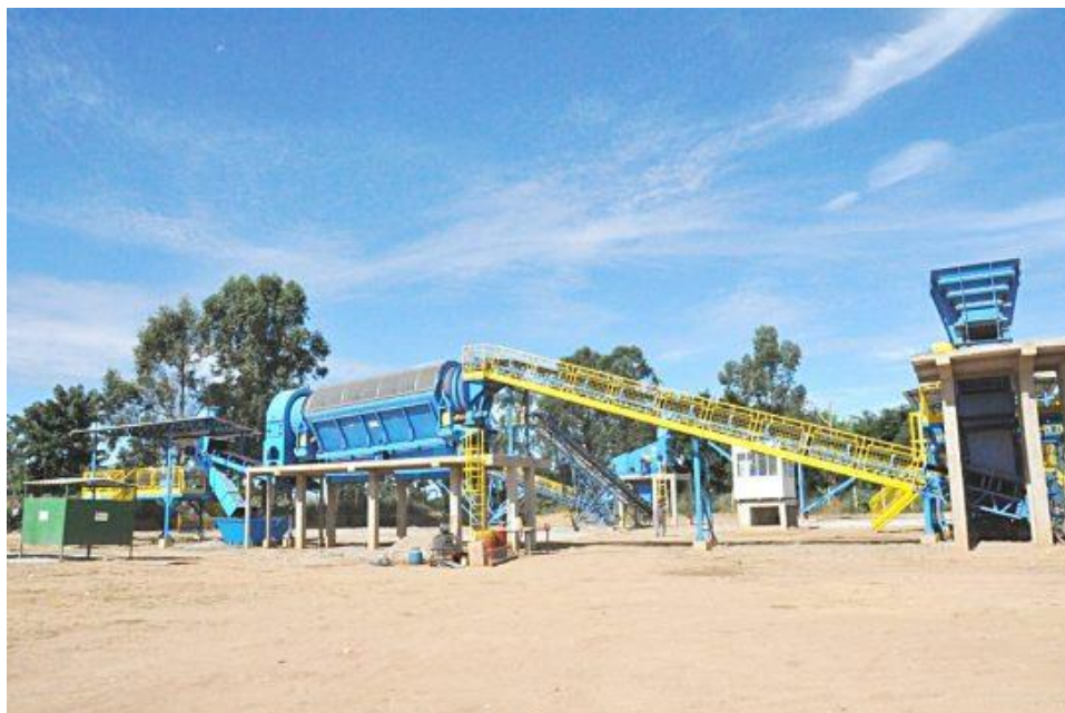
Figura 8: Britador da usina de beneficiamento e britagem de resíduos inertes do município de Campos dos Goytacazes Fonte: J3 News (2018).
