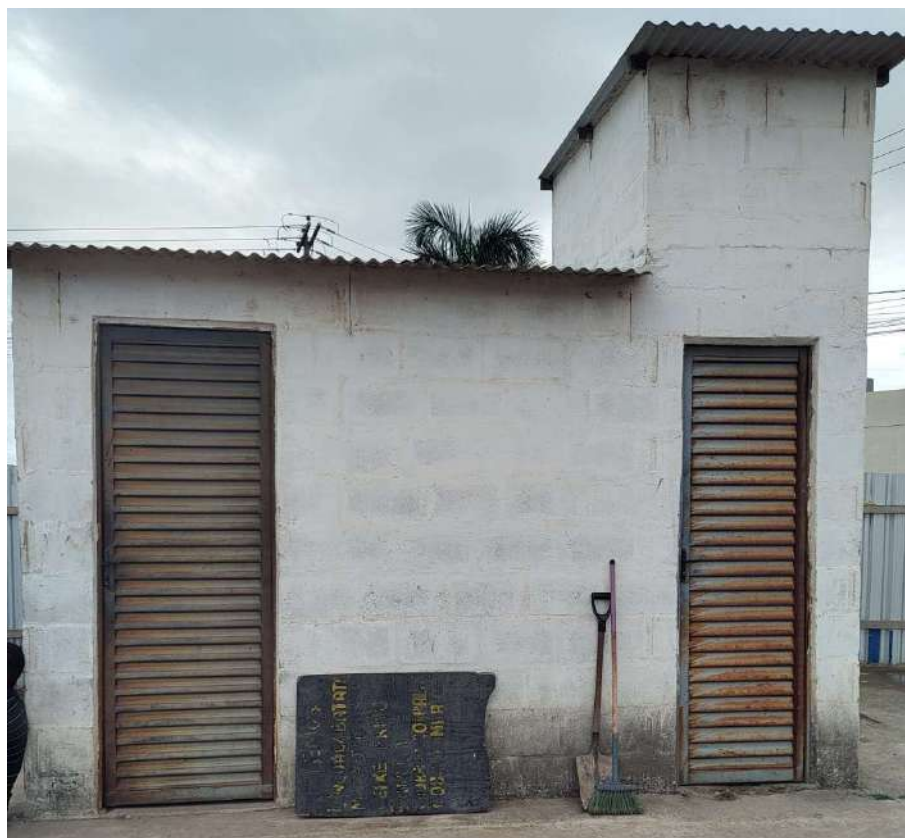
Figura 79: Área reservada para banheiro
