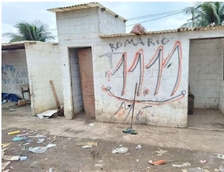
Figura 71: Área reservada para banheiro
