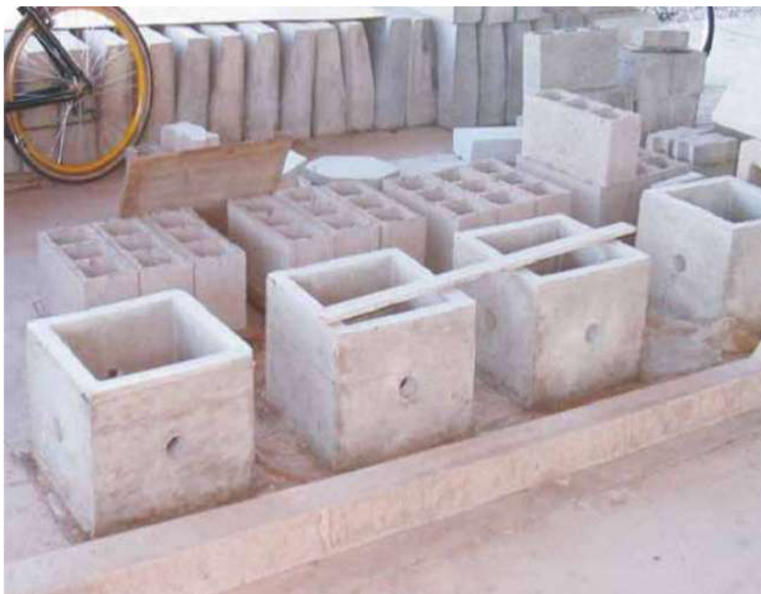
Figura 23: Confeção de caixas de gordura.
