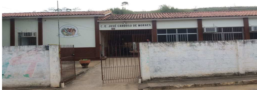
Figura 10: Faixada do Colégio Estadual José Cardoso de Moraes
