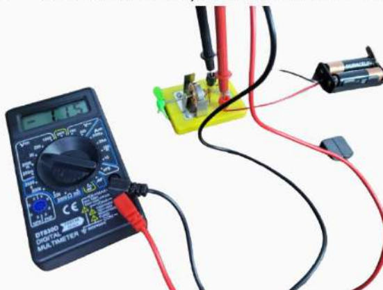
FIGURA 14 - Voltímetro indicando que há tensão com o circuito fechado.
