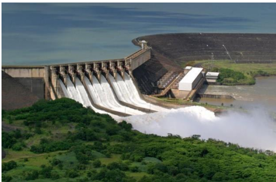
Figura disponível em: http://www.brasil.gov.br/infraestrutura/2016/05/capacidade-instalada-de-geracao-de-energia-atinge-142-610-mw-em-marco/usina.jpg/image
