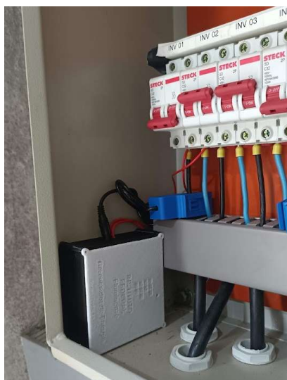
Figura 54 - Montagem do dispositivo no sistema do inversor 1
