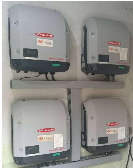
Figura 53 - Inversores Fronius Polo de Inovação
