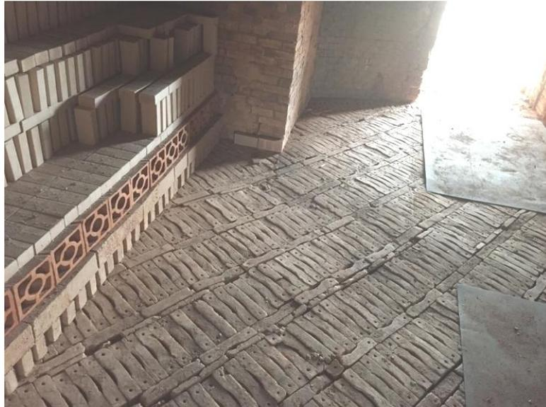
**Figura 2 – Aspectos construtivos do piso do forno (crivos)**
