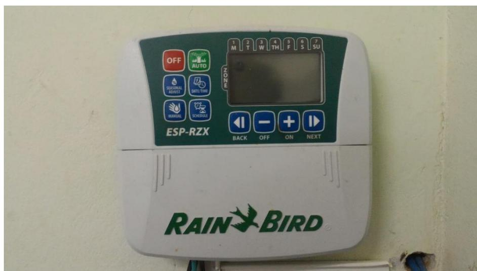
Figura 31 - Controlador Temporizador do Sistema de Irrigação
